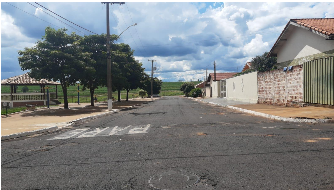
FOTO 04: Vista de quem olha da Rua Agenor Pantaleão para Rua Nafetale Pereira Dias.
