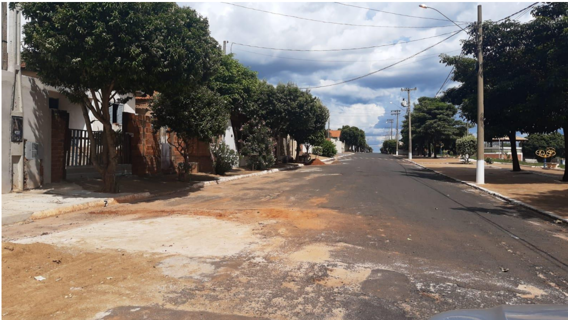
FOTO 02: Vista da Rua Nafetale Pereira Dias.
